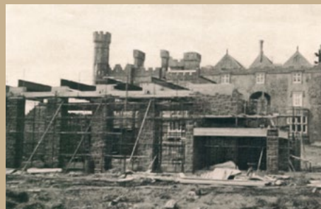
Rozbudowa Donamon o kompleks seminaryjny z kościołem, lata sześćdziesiąte XX w.
