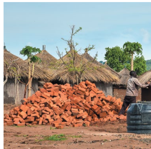
Budowa kaplicy w Bidibidi
