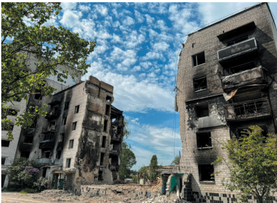
Zniszczenia wojenne w Borodziance, czerwiec 2022 r.
