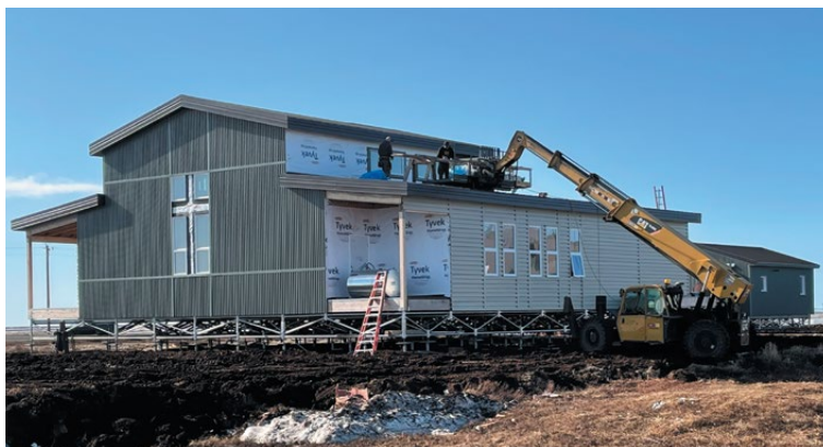
Budowa kościoła w Chefnork
