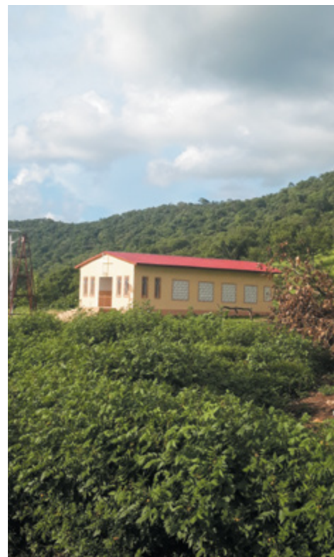
Kaplica w Kagnigbara po położeniu nowego dachu
