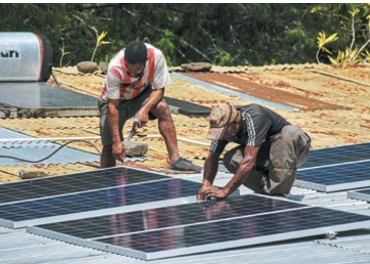
Instalacja paneli słonecznych na dachu
