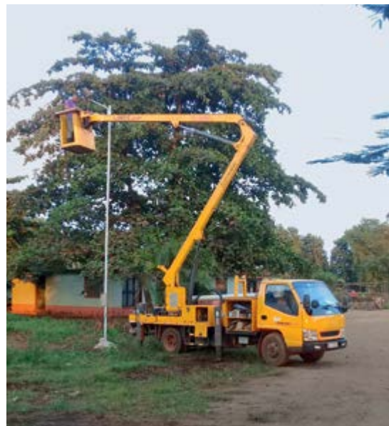
Podłączanie dopływu energii elektrycznej i oświetlenia na terenie, gdzie ma stać kościół
