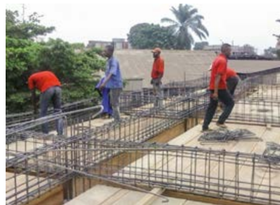
Szkola w trakcie rozbudowy
