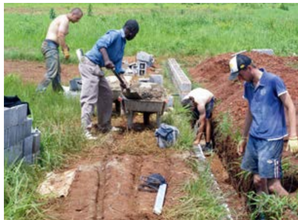
Dawid Bojahn z Kamilem Cebulskim i Maciejem Dutką (przedsiębiorcą i szkoleniowcem w e-biznesie) przy kładzeniu fundamentów pod przedszkole w Lindzie w styczniu 2013 r.
