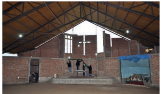
Konstrukcja i wnętrze budowanego kościółka-kaplicy pw. św. Franciszka Solano w argentyńskiej prowincji Juy Juy
