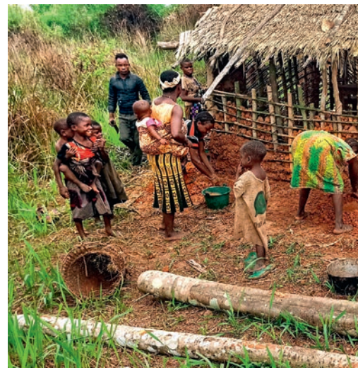
▼ Budowa domu Bayaka
