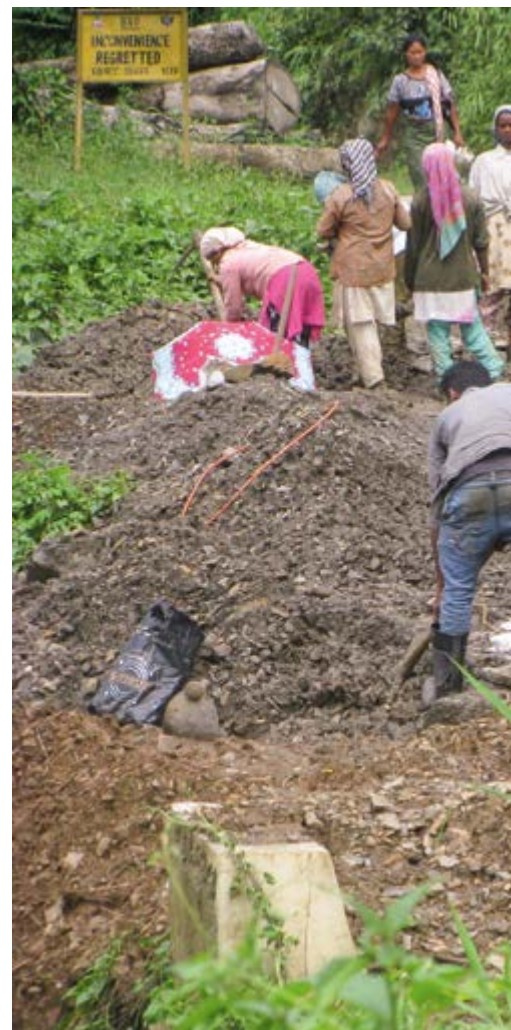
Przy budowie drogi w Nagalandzie
