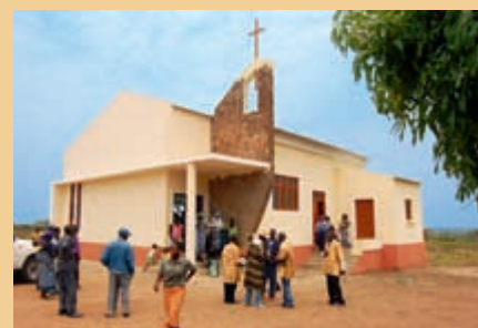
... i po remoncie
