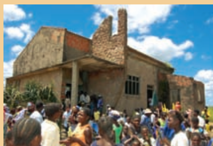
Kościół w Catala przed remontem...
