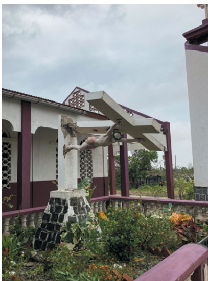
Po przejściu cyklonu – kościół w Normale
